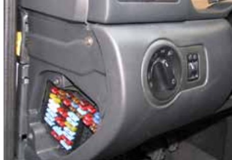
Der Sicherungskasten befindet sich zumeist seitlich © Christian Gasche
